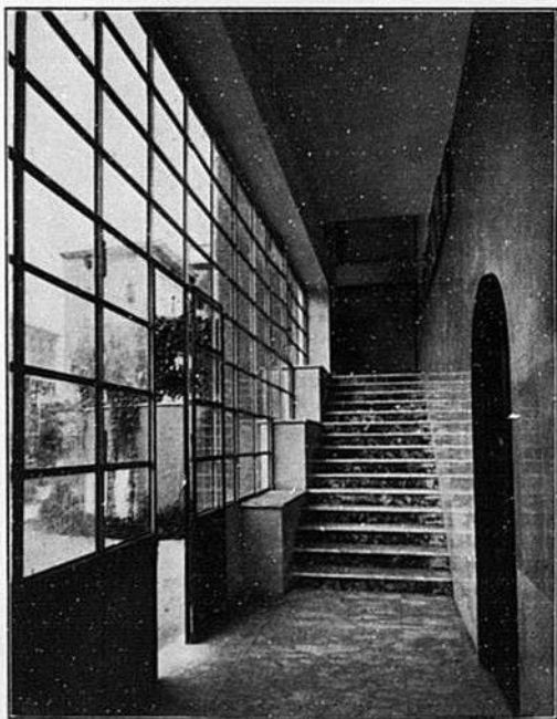
VISTA DELLA SCALA D'ACCESSO AGLI APPARTAMENTI SUPERIORI. Pavimento in marmo, gradini in marmo «calacatta», sottogradi in marmo rosso di Francia, pareti e cornici di marmo artificiale grigio e nero.
